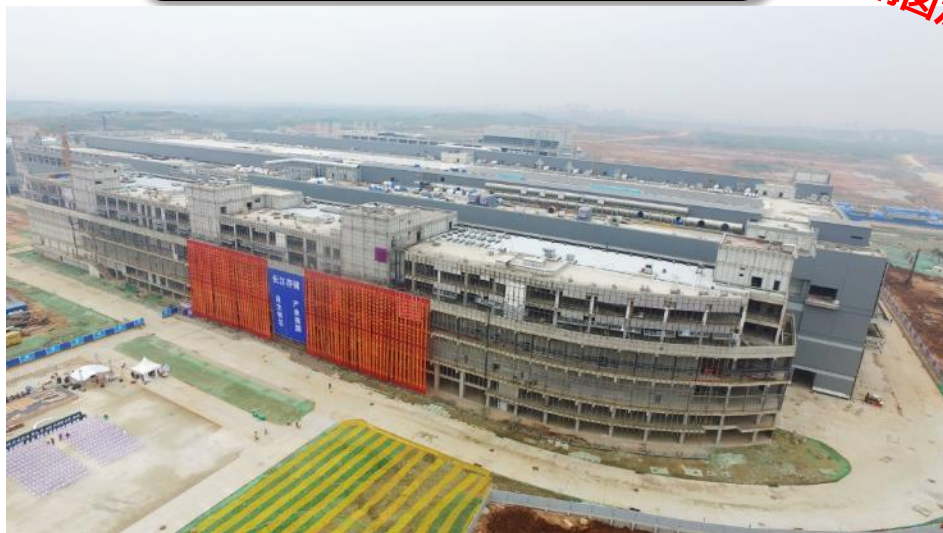
NANDフラッシュメモリの工場建設が急ピッチ (2018年4月)
